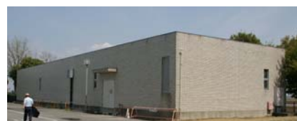
中水システム設備
