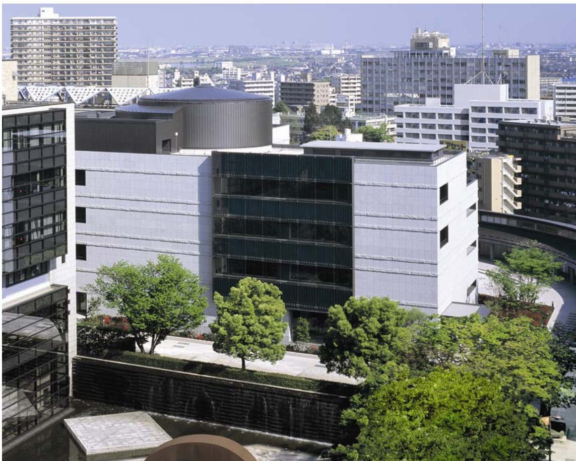
【大学1号館の太陽光発電モジュール組込ガラススクリーン(松戸キャンパス)】
