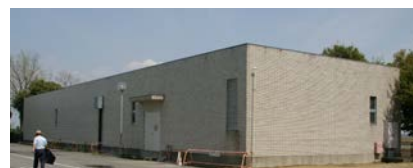
【中水システム設備】
